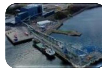
MINI LNG RECEIVING TERMINAL
